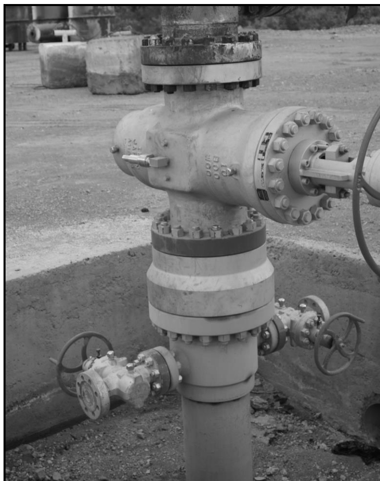
Figura 2.3.5c Esempio fotografico di Testa Pozzo Definitiva
